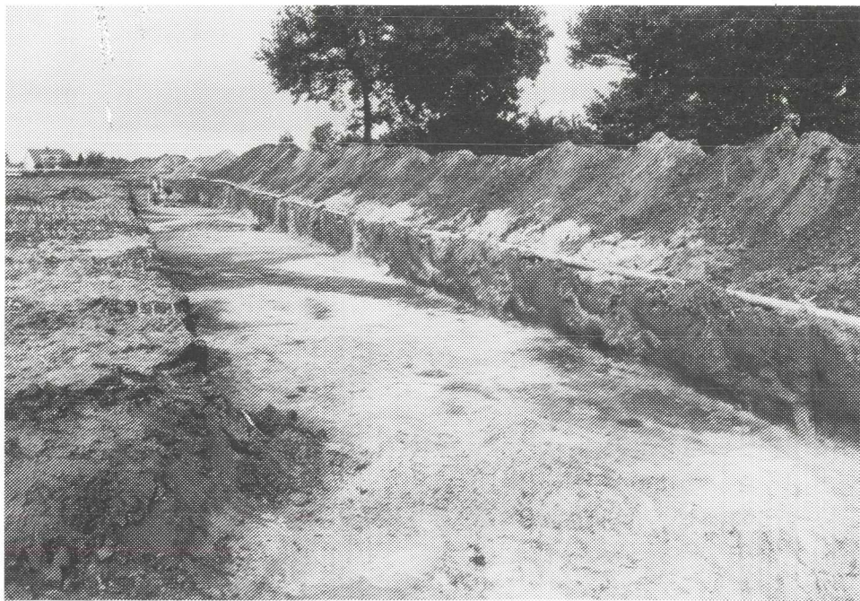
De plaats waar eens "Mariënburgh" heeft gestaan. Riolerings sleuf, gegraven 1981 van Ferdinand Huycklaan naar Eemstraat. Oude funderingen.
