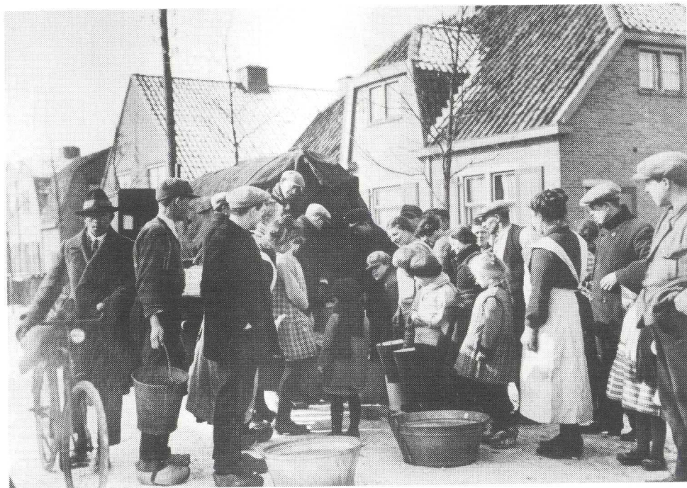
Kranen en pompen, alles bevroren. Febr. 1929.
