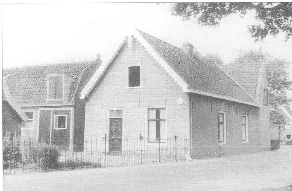
De voormalige meelfabriek, Dorpsstraat 12 Nieuwer ter Aa, in 1956 (coll. Wiebes)
