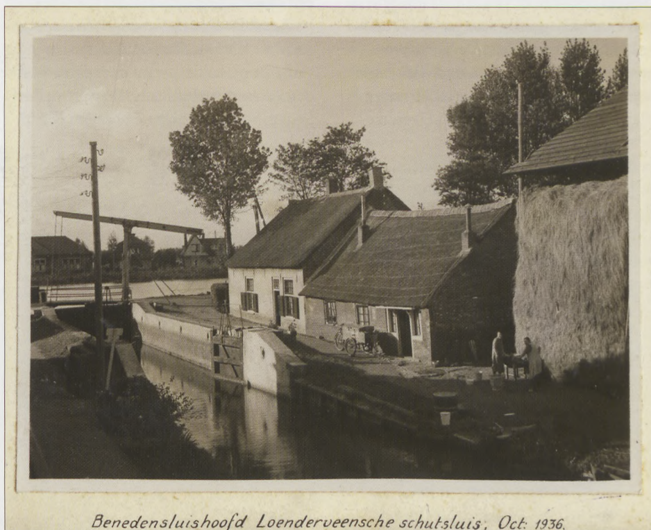
Een foto van de sluis uit 1936, met de oude eiken sluisdeuren. (coll. J. den Besten)
