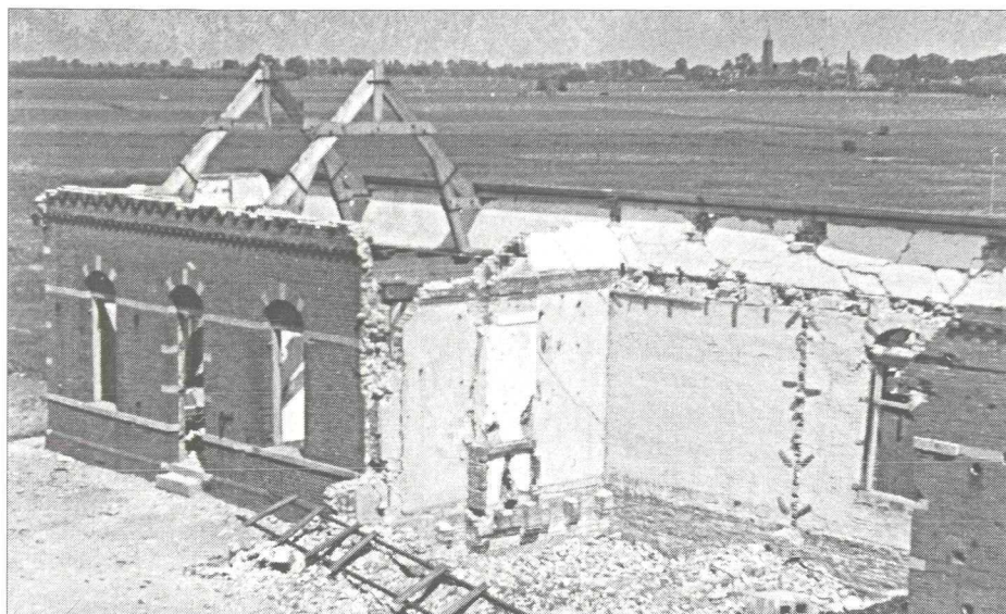
In de laatste maanden van de oorlog beschieten geallieerde piloten regelmatig de spoorlijn Amsterdam-Utrecht en (de bruggen over) het Merwedekanaal. Onder meer de brugwachterswoning te Nieuwershuis wordt geraakt...
