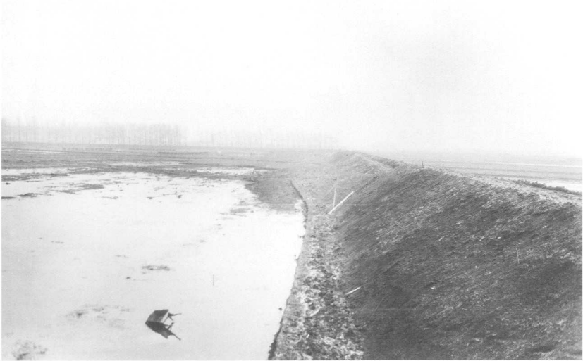
Gezicht op het Amsterdam-Rijnkanaal in aanleg te Utrecht. HUA, cat.nr 43407.
