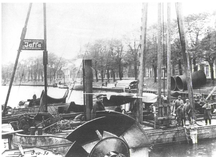
Bouw gemaal bij de Vechtsluizen, Muiden, 1930 (fotocollectie Provincie Utrecht).
