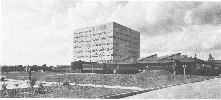
14. Gebouw voor pre-klinische tandheelkunde aan de Helsinkilaan in de Uithof. Op de achtergrond de hoogbouw van de Tandheelkunde in 1975.
