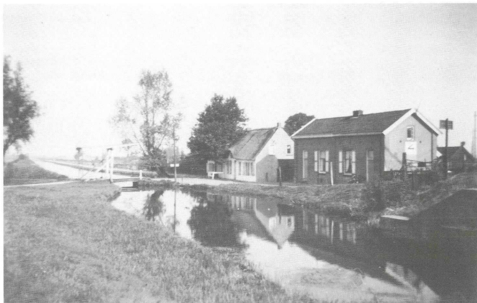
Ophaalbrug over de Bijleveld bij Gerverscop, 1957. Deze brug lag net ten noorden van de plek waar de oude weg van Kockengen naar Harmelen (Wagendijk, Rodendijk) de spoorlijn Breukelen - Woerden bereikt. Dit deel van de Bijleveld is in 1959 gedempt, waarna de brug overbodig was.
