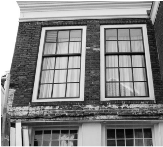
De oostgevel van het voorhuis ter plaatse van het voorheen overdekte plaatsje, dat door afbraak van de 19de-eeuwse keuken niet meer overdekt is. Op de foto is met enige moeite te zien dat de stenen vrij groot zijn.
