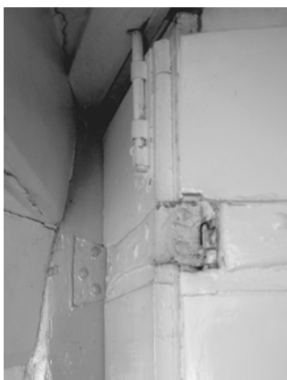
Het dubbelscharnier, achter bevestigd tegen de spil van de trap, komt naar voren langs het smalle deel van de deur dat bovenin is vastgezet met een grendel. Het houdt ten slotte de naar rechts openstaande deur vast. Zo kan de deur, met het smalle deel langs de spil, toch 180° open draaien in de smalle gang.
