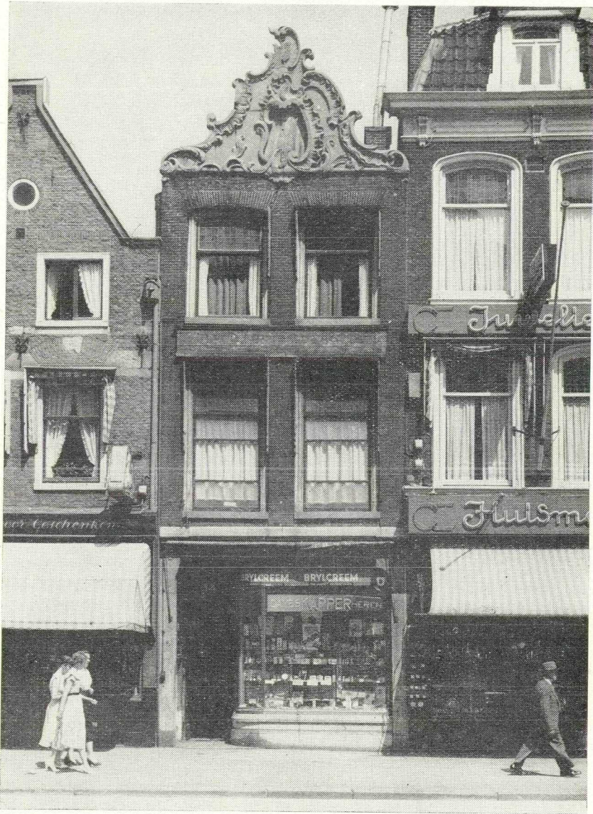
Vredenburg 34. Geveltop vóór de verbouwing van het pand.
