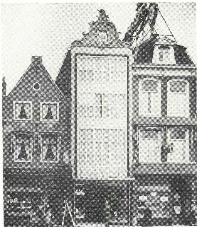
Vredenburg 34. Geveltop na de verbouwing. (Cliché Dagblad „Trouw”)
