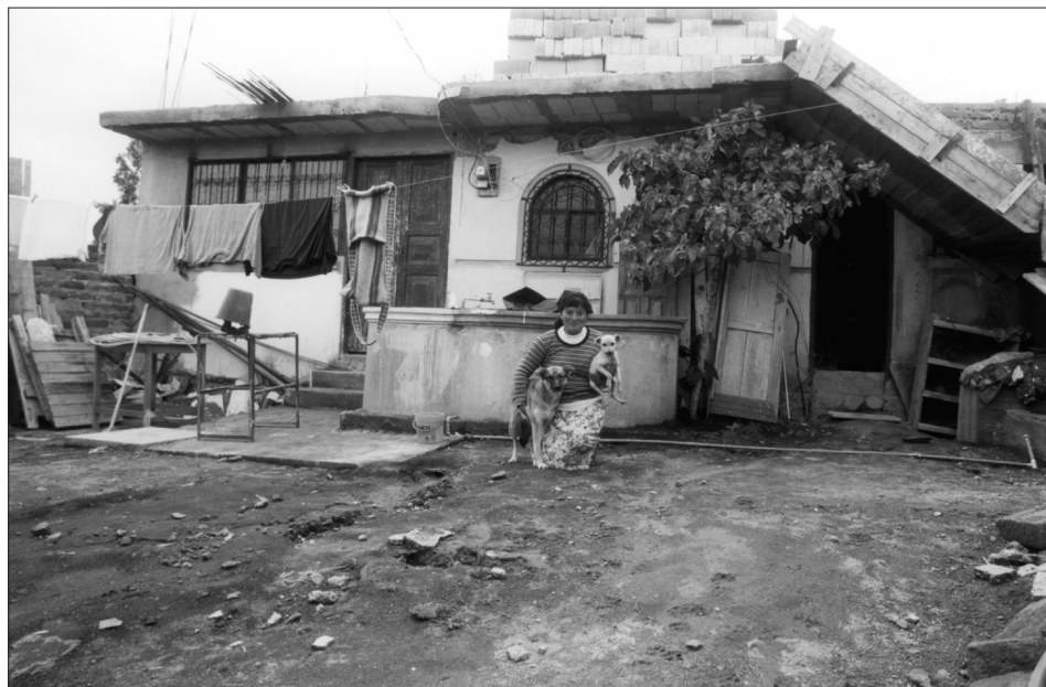
Afbeelding 12: Een villita in aanbouw, Cooperativa Santa Anita
