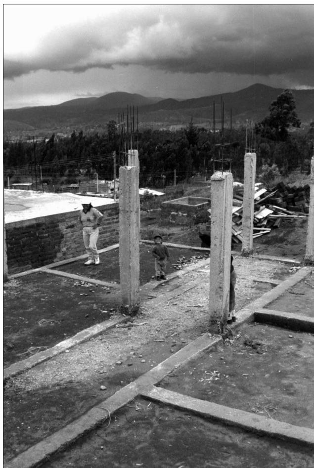
Afbeelding 19: Eerste bouwfase: fundering en kolommen
