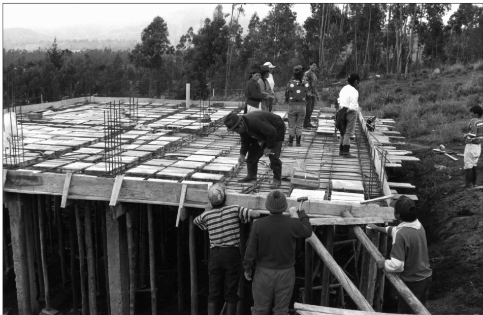
Afbeelding 20: Minga voor de bouw van het dak
