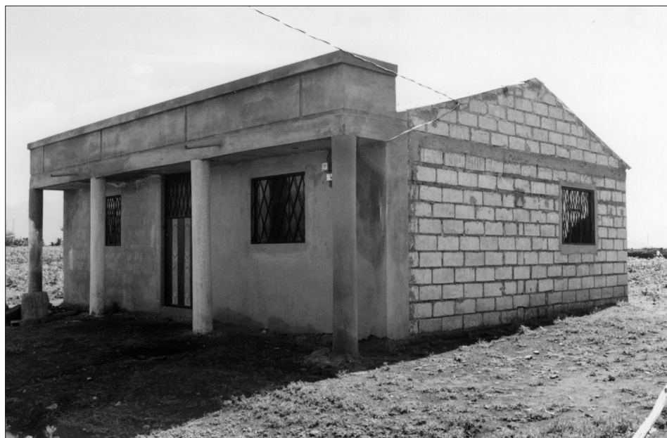
Afbeelding 42: Nieuwbouwwoning in Tunsalao, nabij Riobamba
