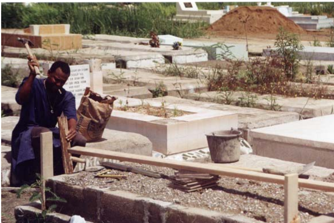
Afbeelding 12: Metselen van een 'kelder', rk-begraafplaats (Louis Noorlander)
