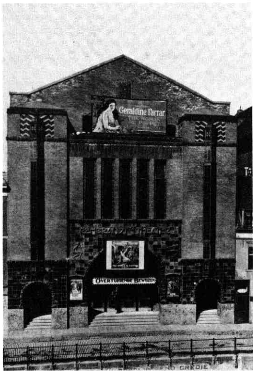
2. De voorgevel van het Rembrandt theater, Oudegracht 73, omstreeks 1930. (Foto: Top. Atlas GAU)
