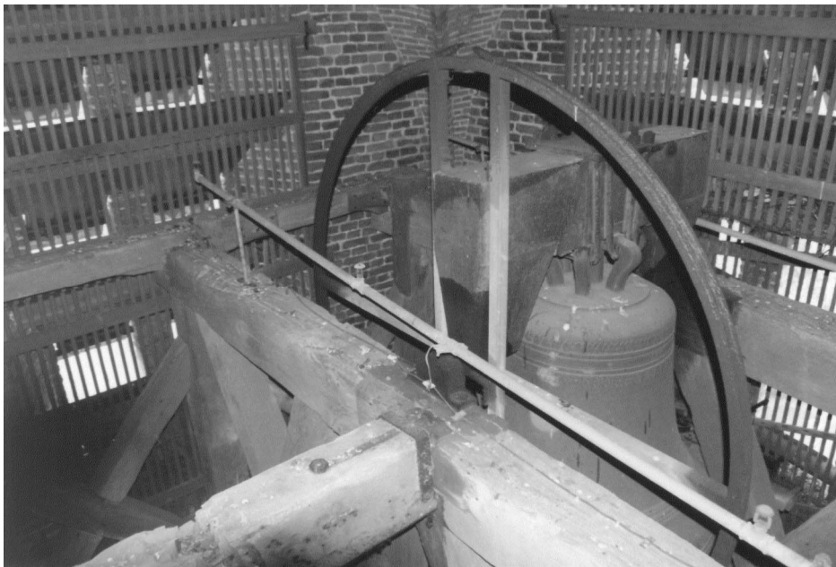
Afb. 1 (foto J. Frantsen) Eikenhouten klokkenstoel. Links de luidbalk van de vroegere kleine klok, rechts de grote luidklok met stalen krukas en luidwiel.
