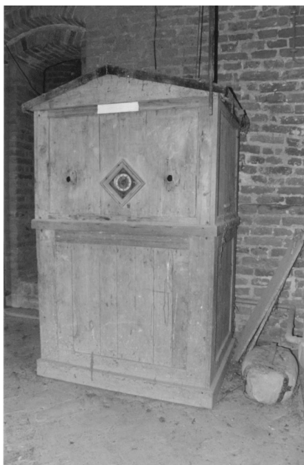
Afb. 2 (foto J. Frantsen) Uurwerk-kabinet (eind 19 e eeuw). Rechts op de grond een natuurstenen gewicht van een vroeger uurwerk.
