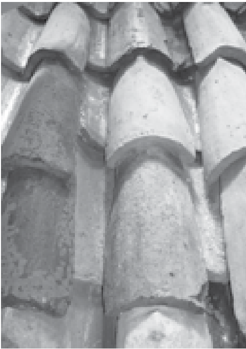
Dakdekking in onder- en bovenpannen
