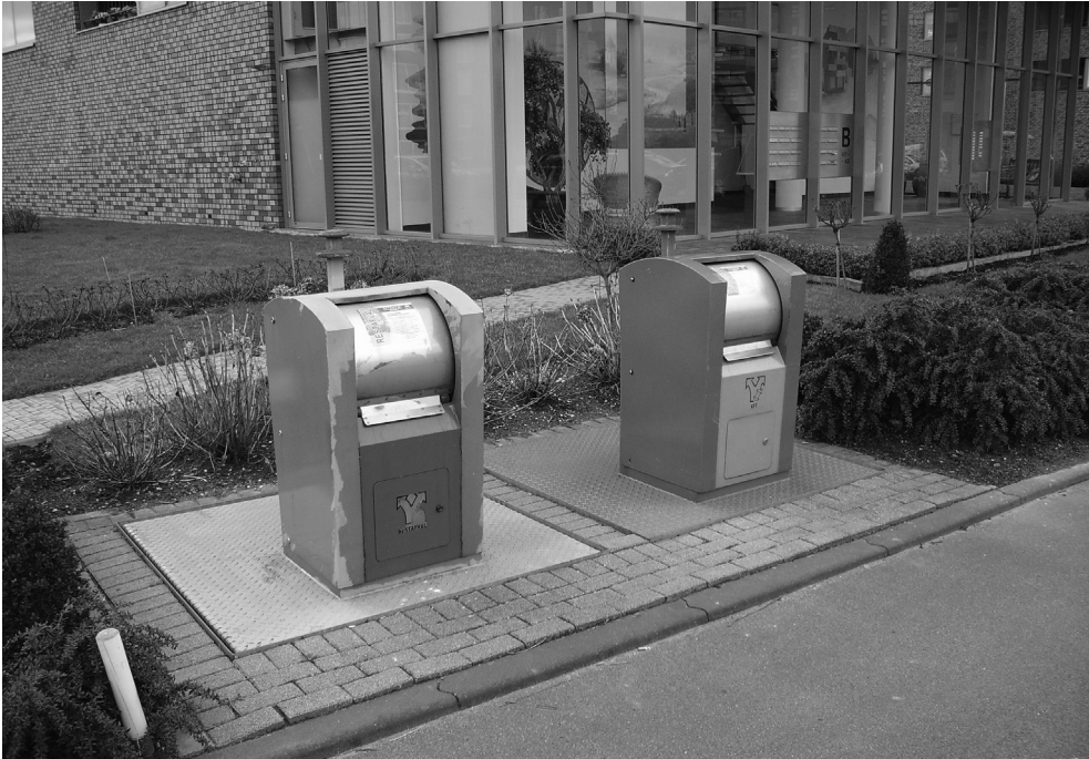
Foto 5.9 Ondergrondse afvalinzameling
